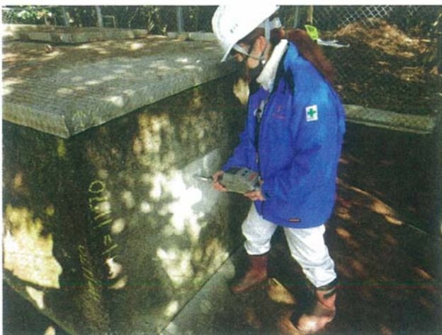
コンクリート強度調査
